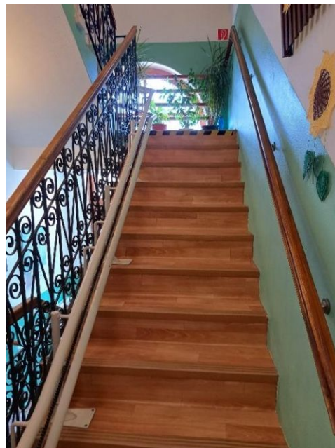
Príloha č. 20: Fotodokumentácia: Schodisko, stoličkový výtah;
